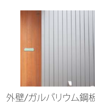
外壁/ガルバリウム鋼板
